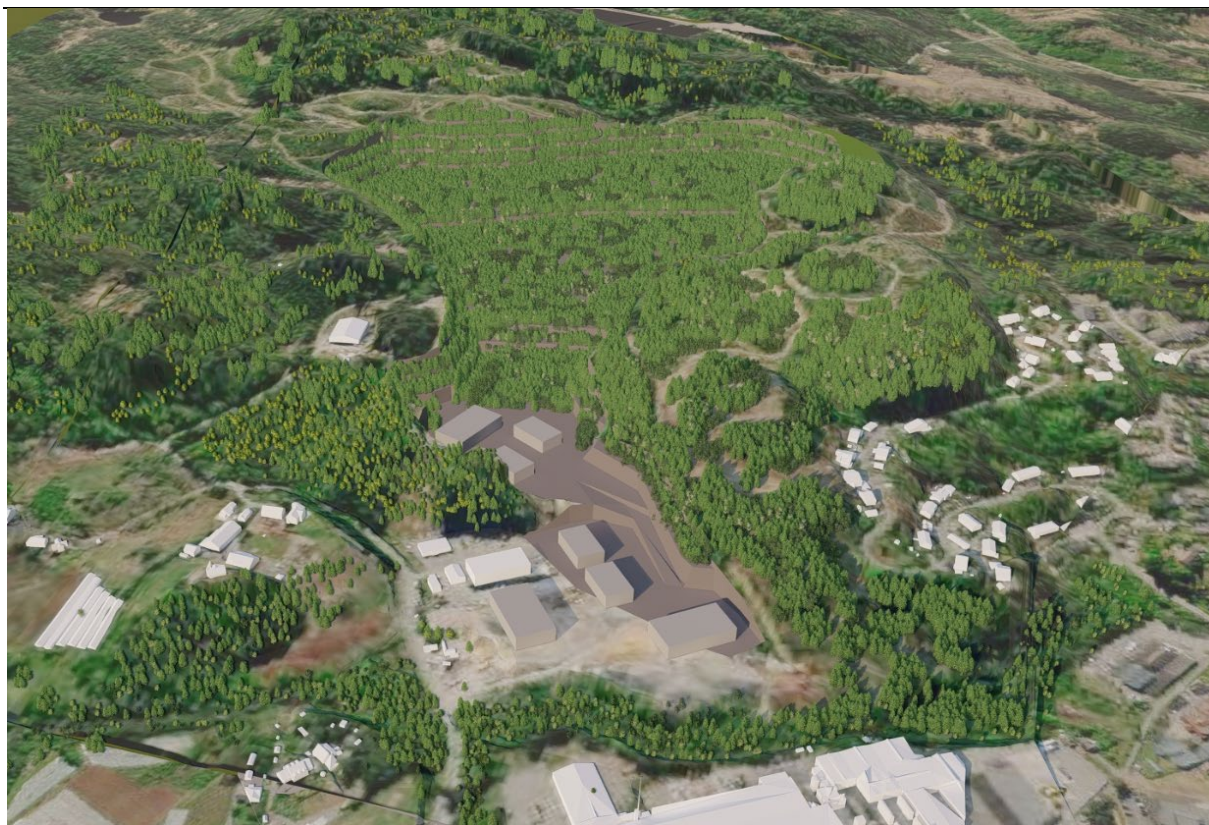
Figur 25. Oversiktsbilde fra 3d-modell som viser ferdig masseuttak sett i fugleperspektiv. Næringsarealet i forkant.
